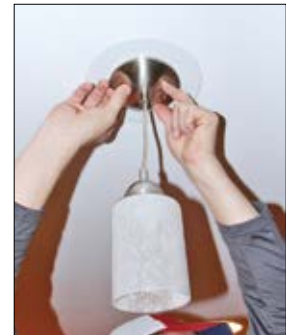
WIRE & INSTALL NEW PENDANT FIXTURE
